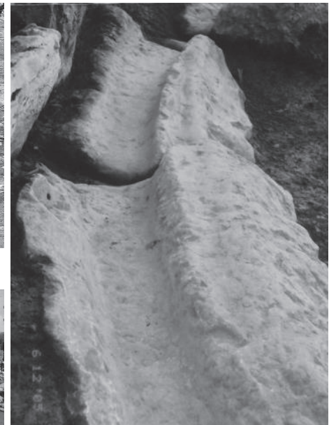
Εικ. 15. Τα σπασμένα μάρμαρα του ρείθρου προκλήθηκαν από τον διερχόμενο πάνω από το ρείθρο δρόμο της γαλλικής μεταλλουργικής εταιρείας.
