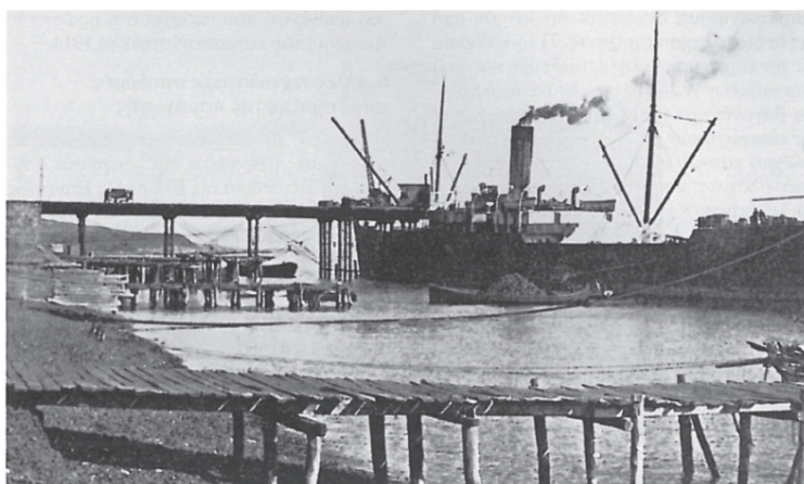
Λιμενικές εγκαταστάσεις της Γαλλικής Σκάλας της εποχής του Μεσοπολέμου (Γ.Κ. Μάνθος, Μεταλλευτικό - Μεταλλουργικό Λαύριο , Λαύριο 1990)
