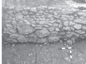
Εικ. 10. Κίτσι, Δ. τμήμα τεχνικού έργου, όψη τχ 2.
