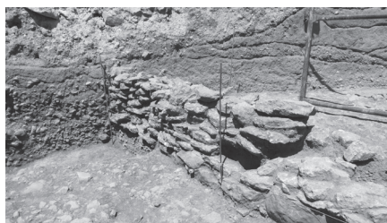
Εικ. 12. Κίτσι, Α. τμήμα τεχνικού έργου, όψη τχ 1.
