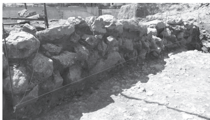
Εικ. 13. Κίτσι, Α. τμήμα τεχνικού έργου, όψη τχ 2.
