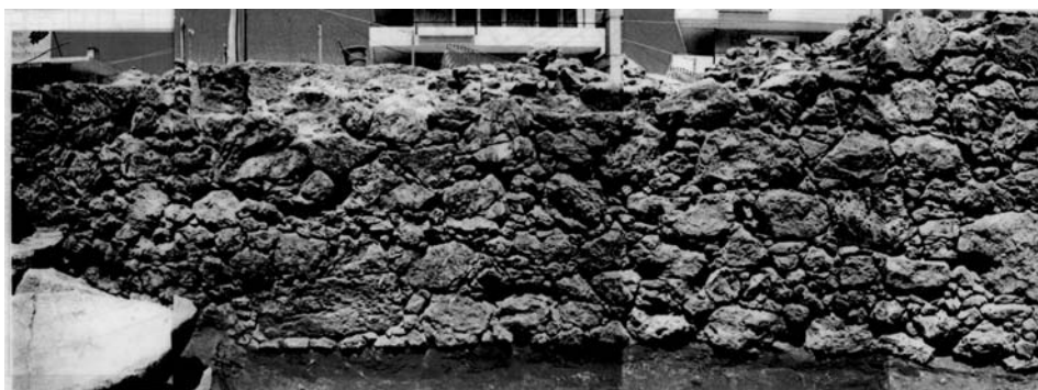
Εικ. 3. Όψη τοίχου 2 από Ν.
