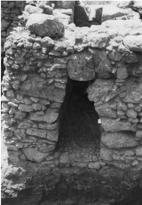
Εικ. 6. Β όψη δεξαμενής.
