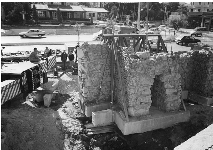
Εικ. 10. Μετακίνηση Α τμήματος κτιρίου α'.
