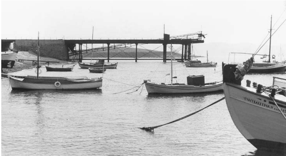
Εικ. 13. Φωτογραφία όπου φαίνεται ο γερανός.
