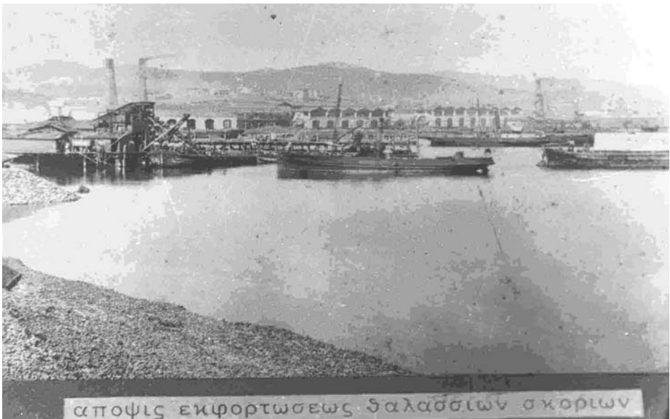
Εικ. 3. Αποψη εκφορτώσεως θαλασσιών σκοριών.
